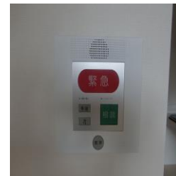
緊急通報装置
